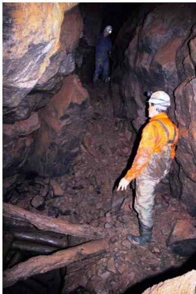
Die wiederaufgewältigten Stollen (siehe Foto) haben eine durchschnittliche Streckenlänge von mehr als 200 m, bei dem mittleren Querschnitt von 1,6 m<sup>2</sup>. Sie stehen größtenteils ohne nötigen Ausbau in standfestem Gebirge. Bergmännische Handarbeit wie Schlägel- und Eisenspuren sind ebenso sichtbar wie auch Sprengspuren, Reste von Bohrpfeifen, die von den angewandten bergbaulichen Techniken zeugen.
